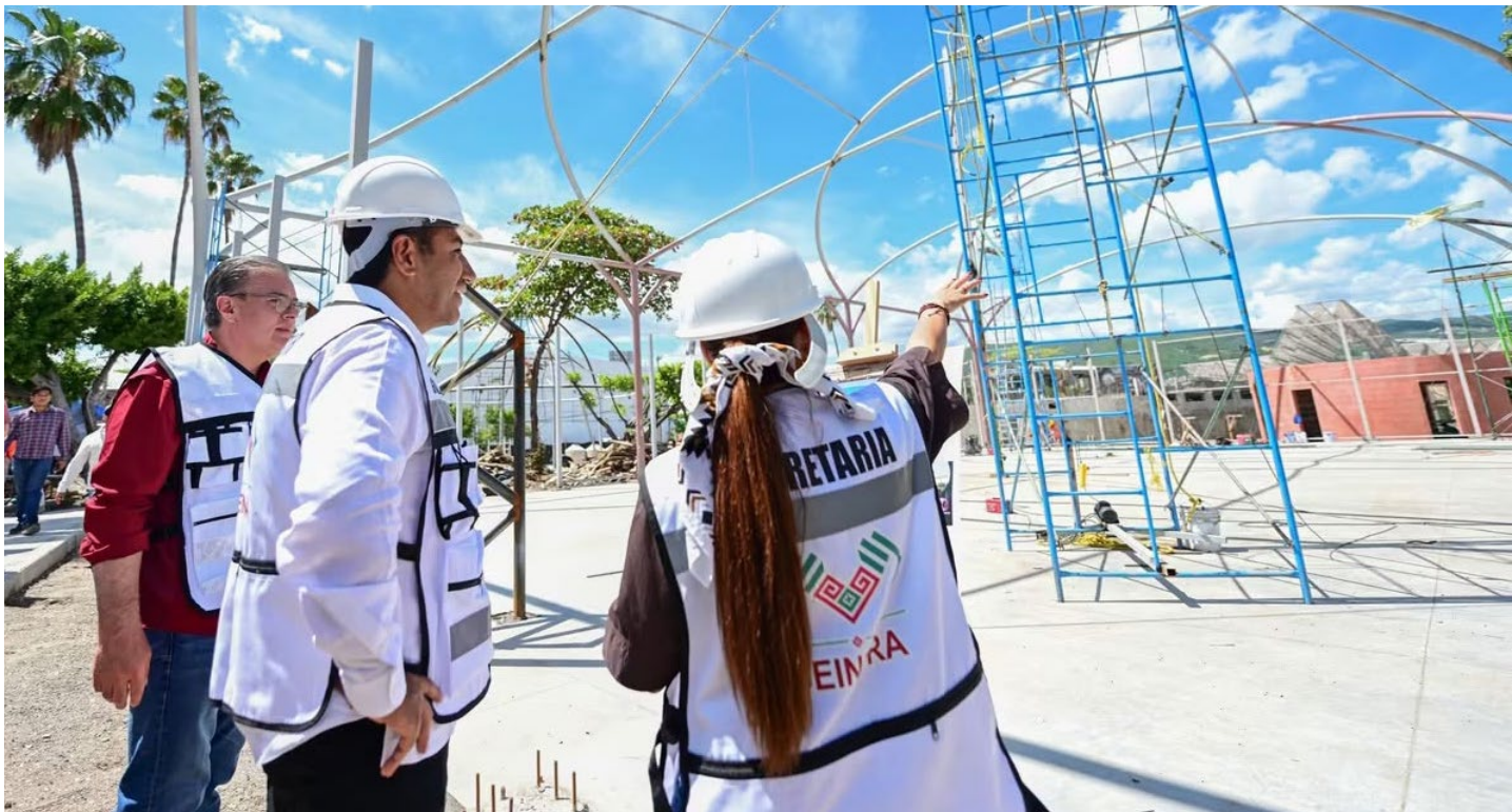
EDUARDO RAMÍREZ SUPERVISA AVANCES DE OBRAS EN LA CAPITAL CHIAPANECA
